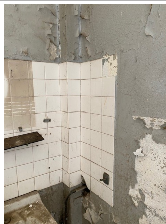
Prélèvement - 0400 : Bâtiment 0061 / RDC / Pièce 016 (Atelier Fer) - Colle de faïence - DE- (Présence d'amiante)
