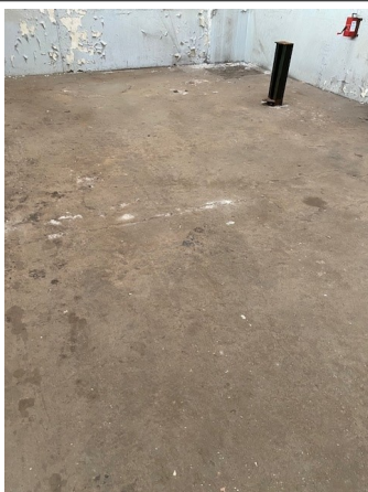
Prélèvement - 0403 : Bâtiment 0061 / RDC / Pièce 016 (Atelier Fer) - Peinture sur béton- (Absence d'amiante)
