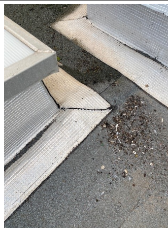
Prélèvement - 0412 : Bâtiment 0061 / RDC / Pièce 016 (Atelier Fer) - Isolant- (Absence d'amiante)
