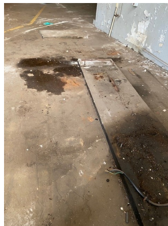
Prélèvement - 0406 : Bâtiment 0061 / RDC / Pièce 016 (Atelier Fer) - Chape maigre- (Absence d'amiante)
