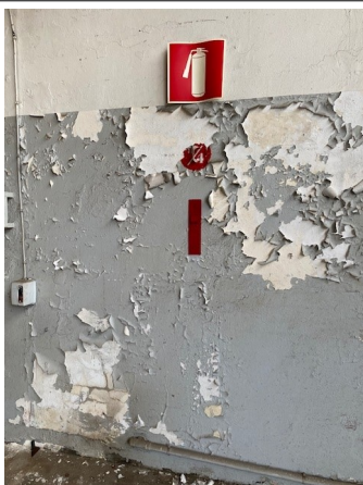
Prélèvement - 0401 : Bâtiment 0061 / RDC / Pièce 016 (Atelier Fer) - Enduit- (Absence d'amiante)
