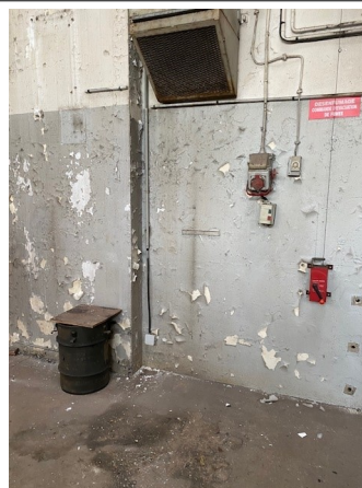
Prélèvement - 0402 : Bâtiment 0061 / RDC / Pièce 016 (Atelier Fer) - Enduit- (Absence d'amiante)
